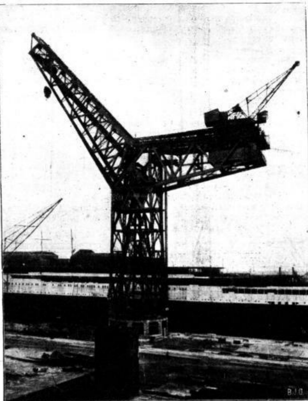
Ein technisches Niesenwerk. (Mit Text.)
