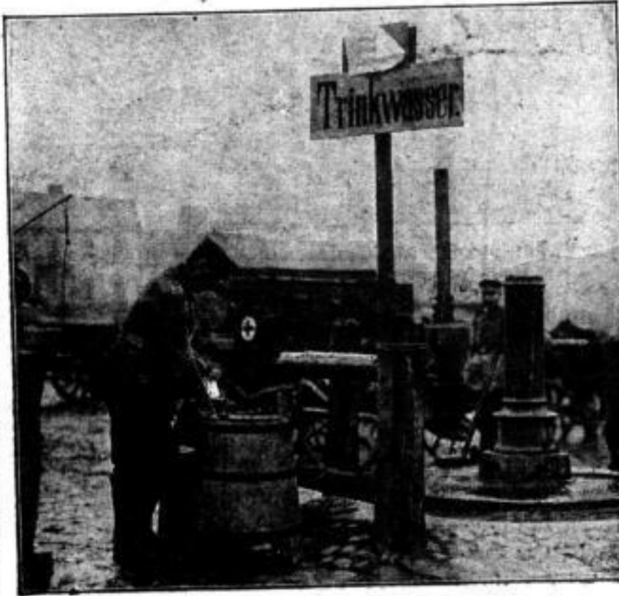
Zur Trinkwasserversorgung der deutschen Truppen in Russisch-Polen.
