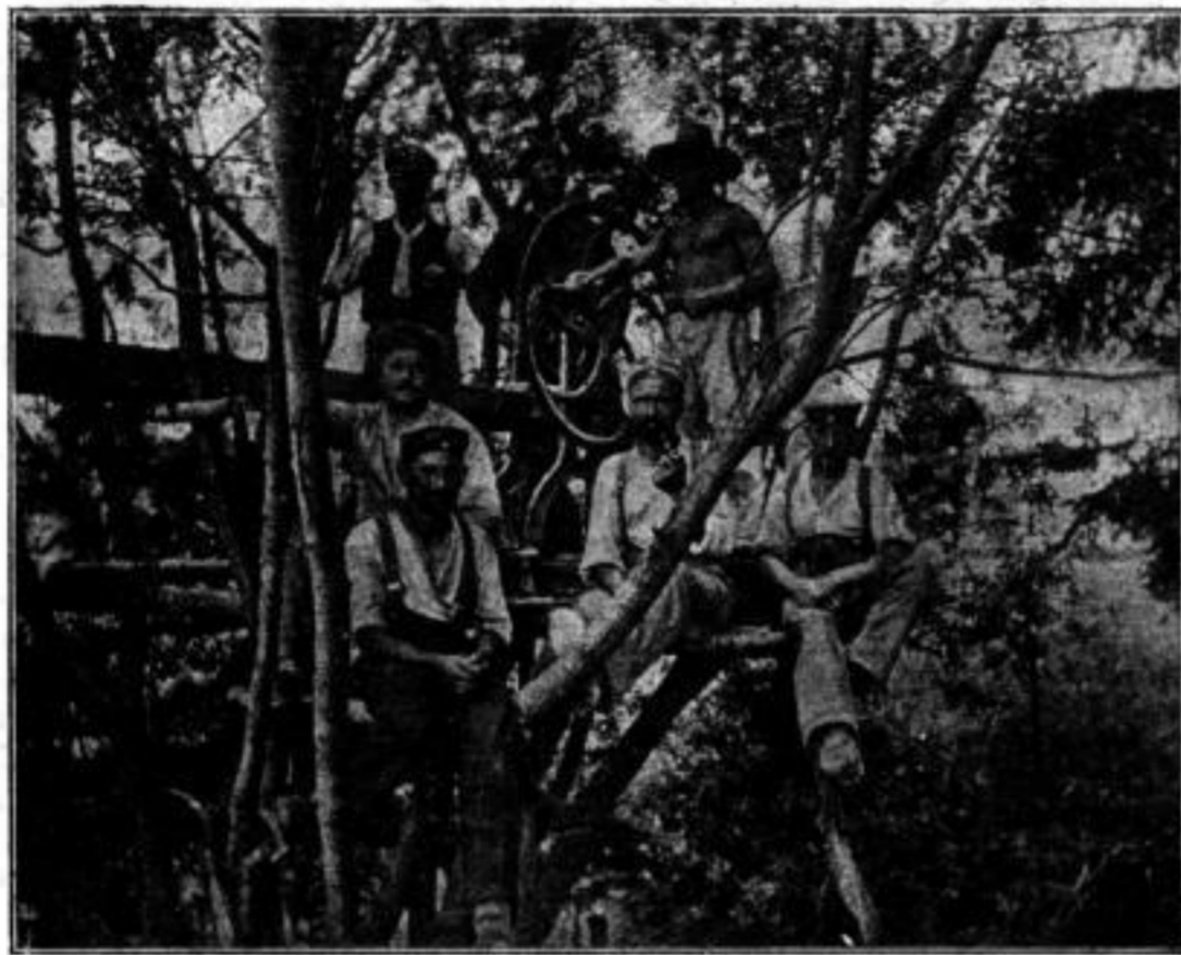
Pumpvorrichtung zum Entwässern und Trockenhalten von Schützengräben.
