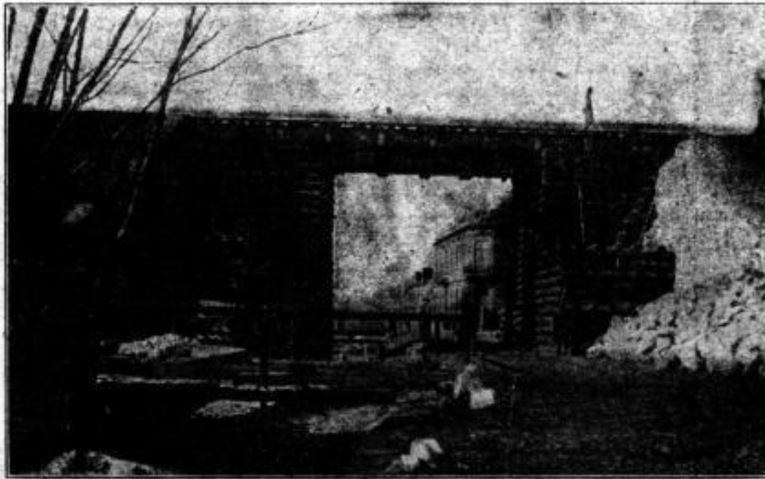
Notbrückenbau aus Bahnschwellen.
