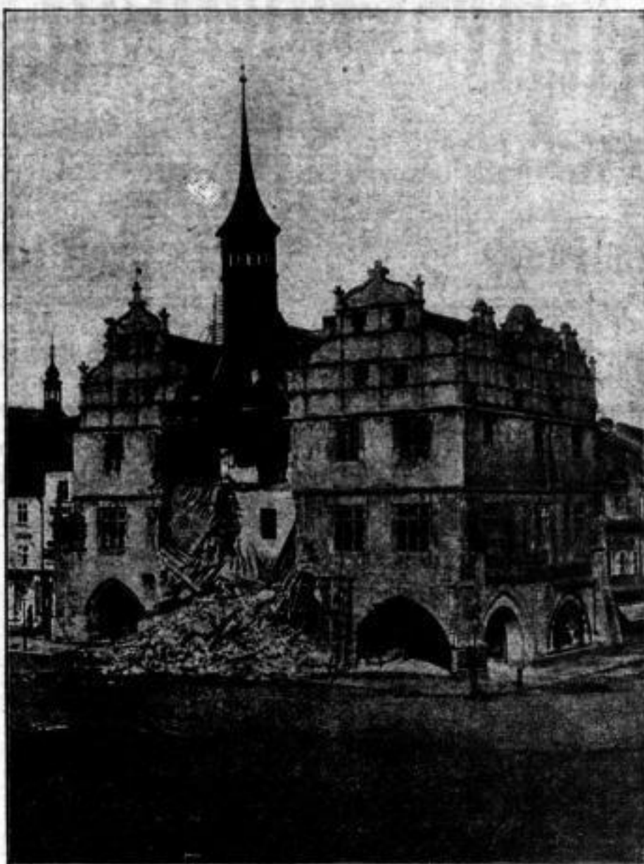
Der Einsturz des Leitmayer Rathhauses. (Mit Text.)
