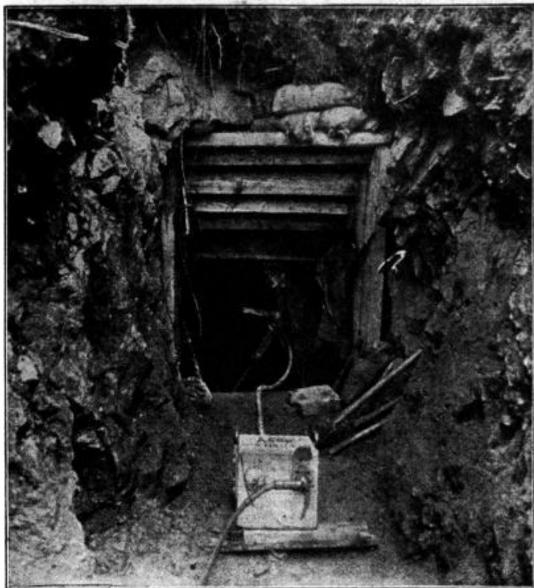
Von den Minenkämpfen in den Vogesen: Elektrischer Gesteinsbohrer in einem Felsen. Phot. Wipperling. (Zensiert Generalstab.)
