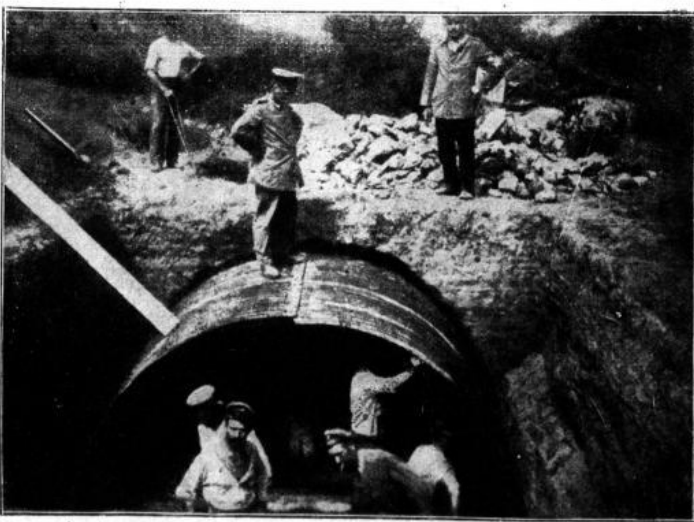
Bau eines bombensicheren Unterstandes in Mazedonien.
