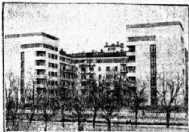
Im Fünfjahrplan des Aufbaues geht die Errichtung moderner Arbeiterwohnungen mit Kleinstwohnungen vorwärts. Unser Bild zeigt die charakteristischsten Neubauten
