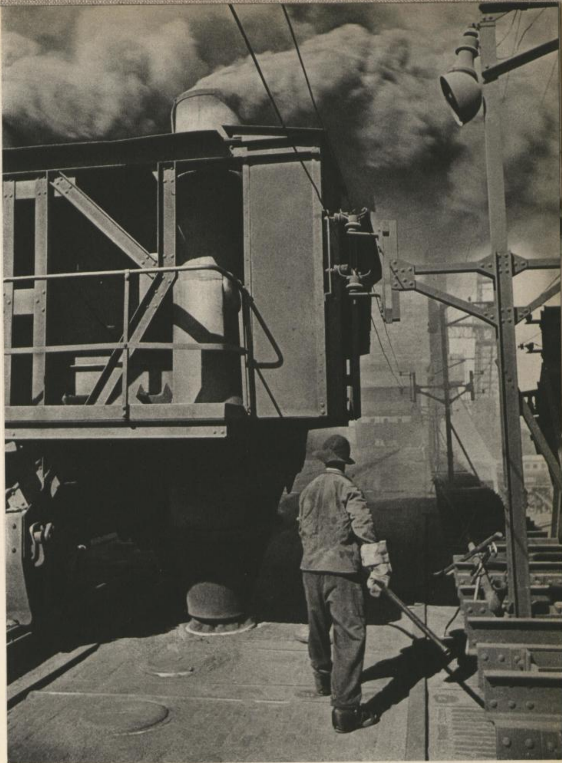
Einfüllen der Kohle in den Koksofen · Putting the Coal in the Coke Oven · Remplissage de houille dans le four à coke
