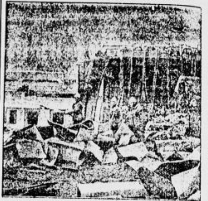
Die Brandstätte im Pariser Zentral-Telephonamt Carnot, das durch ein Riesenfener größtenteils zerstört wurde.
