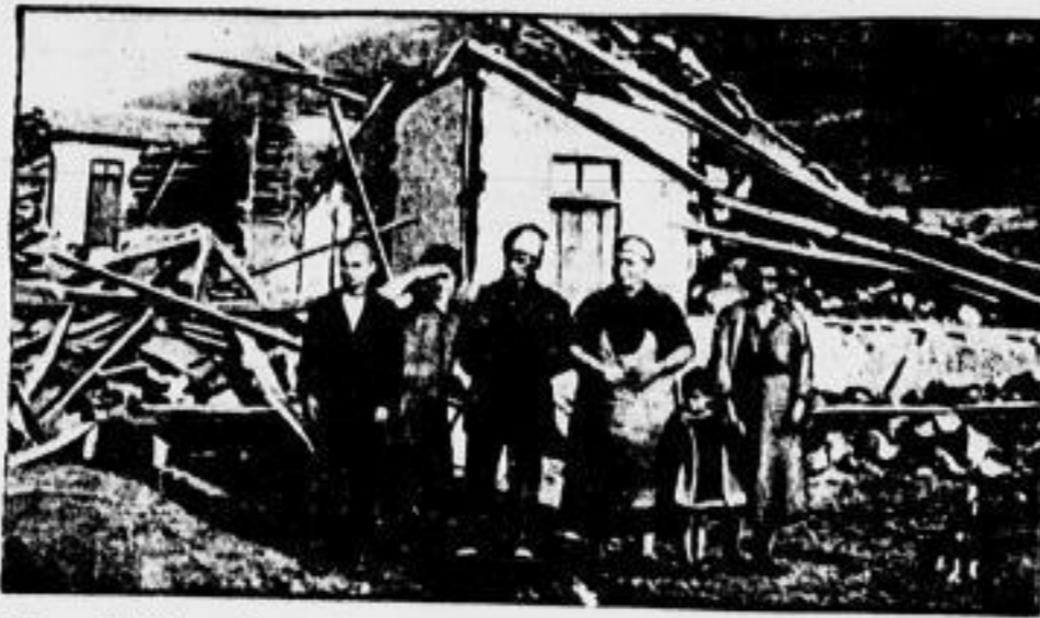
vollkommen zerstört ist.
