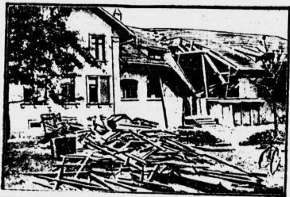
Der Einsturz in St. Margareten bei dem infolge kapitalistischer Profitgier 10 Arbeiter getötet und 40 schwer verwundet worden sind. Den Kapitalisten, die dieses ungeheure Verbrechen verschuldet haben, ist bisher kein Haar gekrümmt worden
