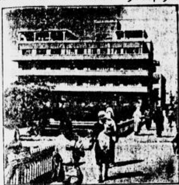
Unser Bild zeigt einen Winkel der schönen neuen Arbeiterstadt in Baku, wo früher die Arbeiter in den verrußten Hütten, mitten im Naphthagebiet, hausen mußten
