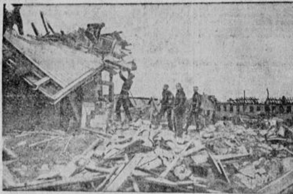
Aufräumarbeiten in den zerstörten Straßen Neunkirchens.
