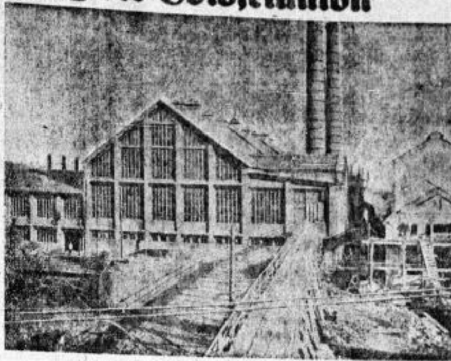
Neues Großkraftwerk in der Ukraine
