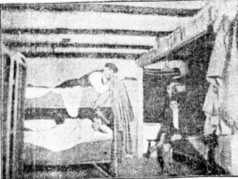
Ehemalige Werkstatt mit Brettverschlägen ausgebaut zu Wohnbaracken. Schränke sind zu eng, Kleider müssen an Balken aufgehängt werden (rechts im Bild) — Ungezieser, Mäuse usw. fressen die Sachen an. Im Winter ungeheizt. Kohlen müssen die Barackenbewohner selbst kaufen. (Siemens-Fabrik)
