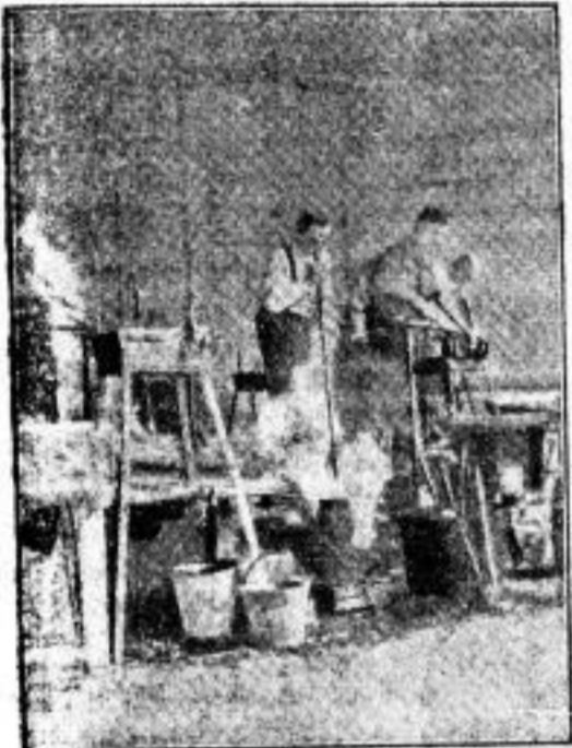
Auf der Bohle vor den Wannenschern Glask, Vorformen des Glases an der Pleße mit dem Holzstößel und Einblasen in die Form
