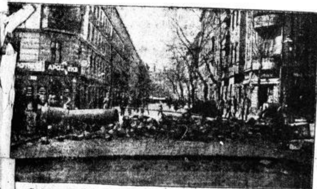
Wesperre Straßen und Barricaden, die von Berliner Arbeitern in Abwehr gegen den Polizeiterror errichtet wurden
