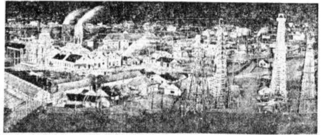
Am 24. des vorigen Jahres ist in dem russischen Erdölgebiet von Mazedonien eine Sonde in Brand geraten, der bis heute noch nicht gelöscht werden konnte, obwohl ein Stab von Technikern und Ingenieuren an der Bekämpfung des Feuers arbeitet. Das von dem Feuer bisher vernichtete Petroleum wird mit Hunderten von Millionen bewertet
