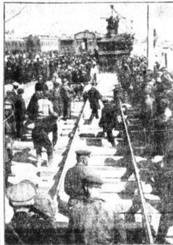
Unser Bild zeigt die Verengung der beiden Schienenstränge. Die Arbeiter befestigen die letzten Schrauben. Einige Minuten später fährt unter brausendem Jubel aller von nah und fern herbeizustehenden Zuschauer der erste Eisenbahnzug über die verengten Strecken.
