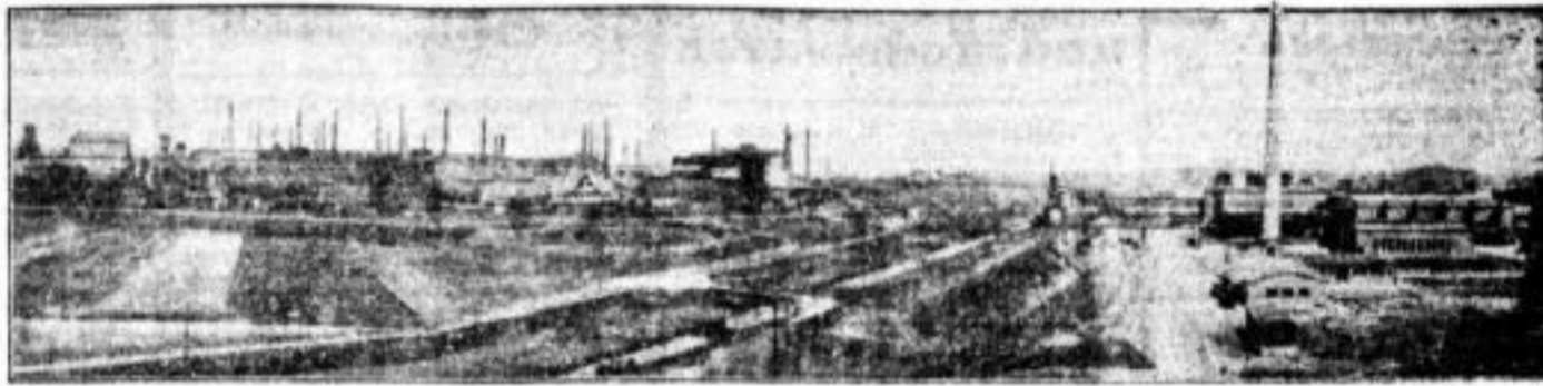
Generator Kupferhütte Gottesbehaltungs-Silberhütte Bleihütte Bessermerei
