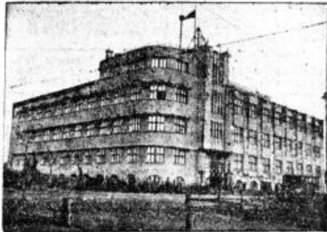
Das Gebäude der Bauleitung
