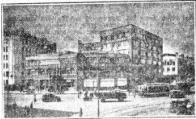
Die Architektur des neuen Moskau
