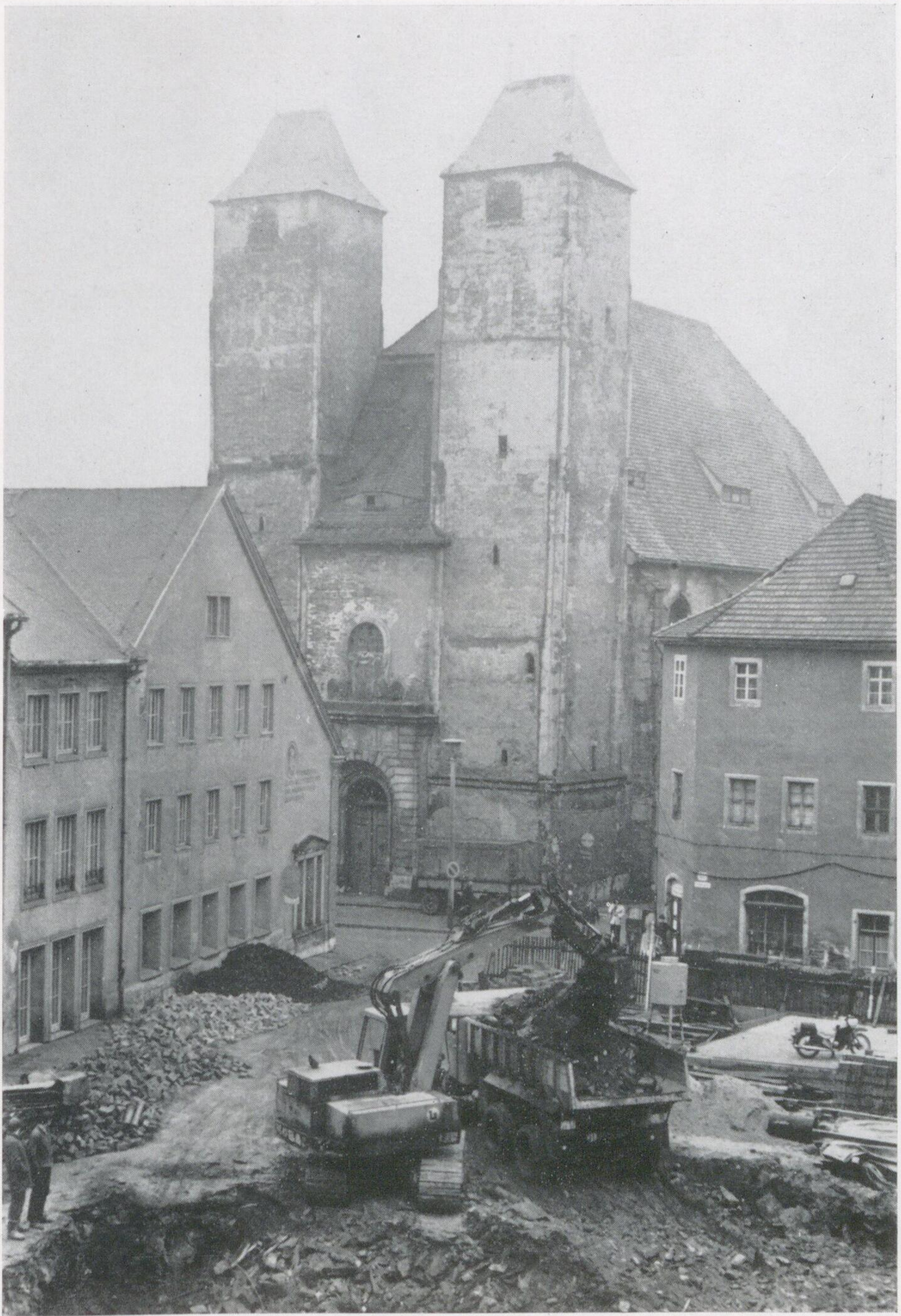
Taf. 21. Freiberg, Borngasse. Blick von Südwesten über die Baustelle zur Nikolaikirche.
