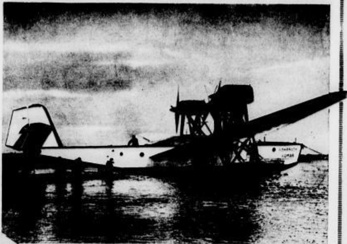
Der „Komar“, das neue dreimotorige Rohrbach-Flugzeug, das für einen Ozeanverkehr bestimmt ist, wurde fertiggestellt und hat sich bei den Probeflügen bei Travemünde bewährt. Es wiegt 15000 Kilogramm, das ist die Ladung von einundbeinhalf Güterwagen der Reichsbahn Graf
