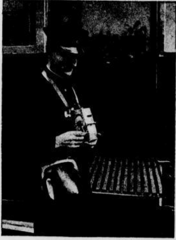
Fahrtkartenautomaten werden jetzt versuchsweise auf der Berliner Straßenbahn eingeführt. Sie drucken die Fahrkarten, nummerieren und zählen sie Atlantle
