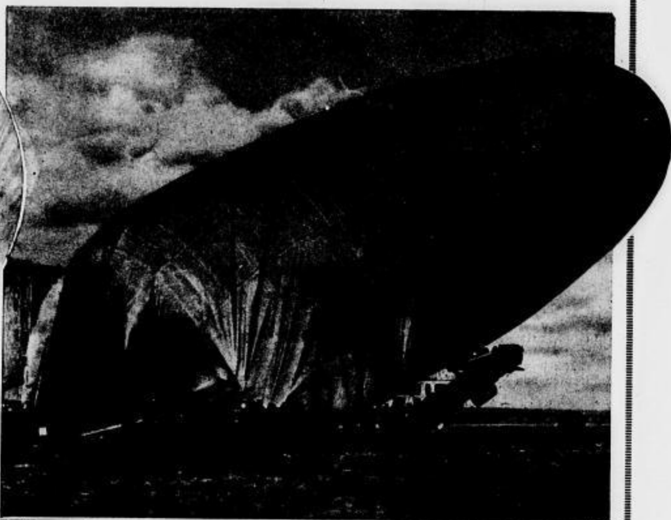
Nicht jedes Luftschiff landet glatt! An den Landungsschwierigkeiten, die der „Graf Zeppelin“ trotz stürmischen Wetters meisterte, scheiterte ein amerikanisches Marineluftschiff. Sein Heck schlug auf den Boden und das Gerüst zerbrach. Die Insassen wurden nicht verletzt New York Times
