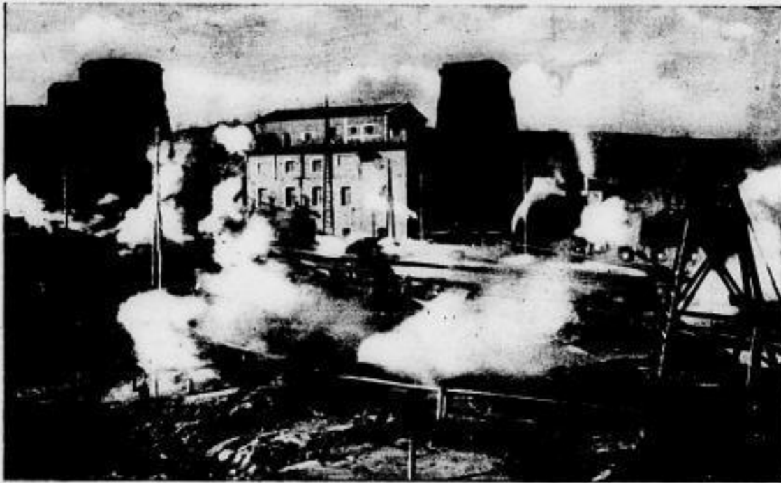
Das Kraftwerk von Barberis in Toskana, Italien. Bezeichnend sind die Röhrenanlagen, die die natürlichen (teils noch in die Luft ausströmenden) Erddämpfe in das Umformwerk leiten
