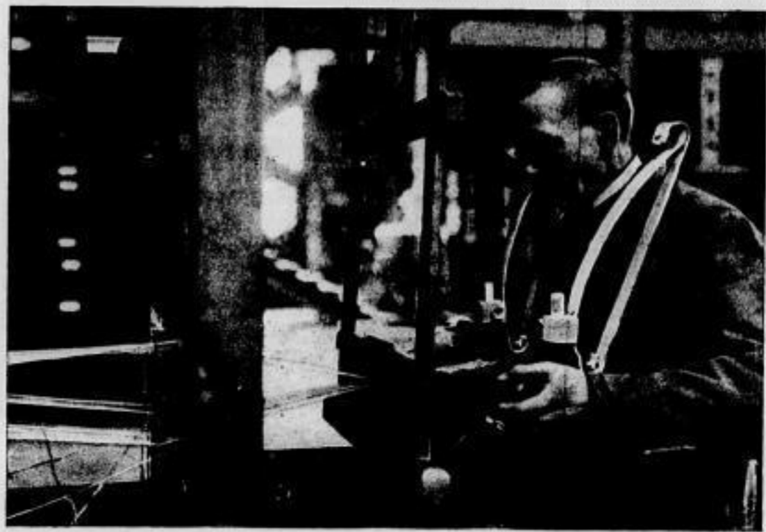
Zum 25-jährigen Bestehen des Deutschen Arbeiterschutzmuseums in Berlin, das eine „ständige Ausstellung für Arbeiterwohlfahrt“ enthält. — Bild oben: Ein Weber wird durch eine entsprechende Vorrichtung zu geradem Sitzen gezwungen, um Schädigungen der inneren Organe vorzubeugen. — Bild links: Augenschutz gegen abspringende Teile beim Schleifen Photothek
