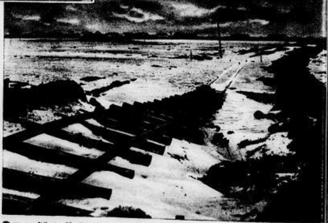
Der zerstörte Bahndamm der Sylter Inselbahn, die Hörnum mit Westerland verbindet. Die Verheerungen auf Sylt scheinen deshalb besonders groß geworden zu sein, weil der neue Eisenbahndamm, der Westerland mit dem Festland verbindet, wie eine Fallsperrre wirkte. Er selbst hielt zwar den ankürmenden Fluten stand, doch hatte gerade deshalb das hinter ihm liegende Wasser keinen Abfluß und wurde dadurch vom Sturm in das ungeschützte Hinterland getrieben
