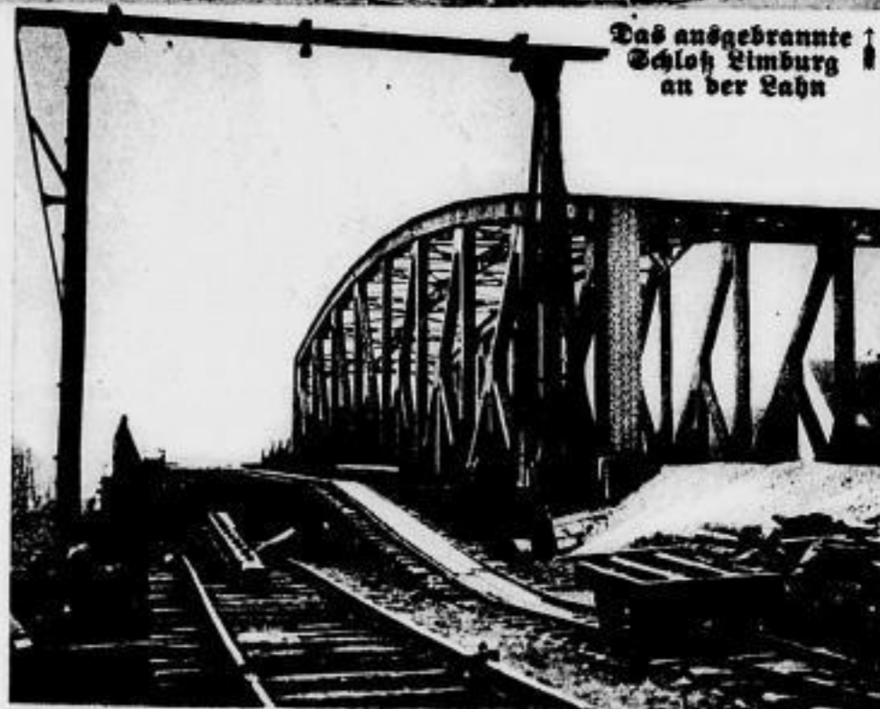
Die neue im Bau befindliche Kanalbrücke im Zuge der belgischen Eisenbahnstrecke Antwerpen-Essen Sie wird durch den viergleisigen Ausbau dieser bisher zweigleisigen Bahn- strecke erforderlich, die auch in der Veröffentlichung des Utrechtsch Dagblad (Utrechtsch Tageblatt) über das französisch-belgische Militärabkommen genannt ist
