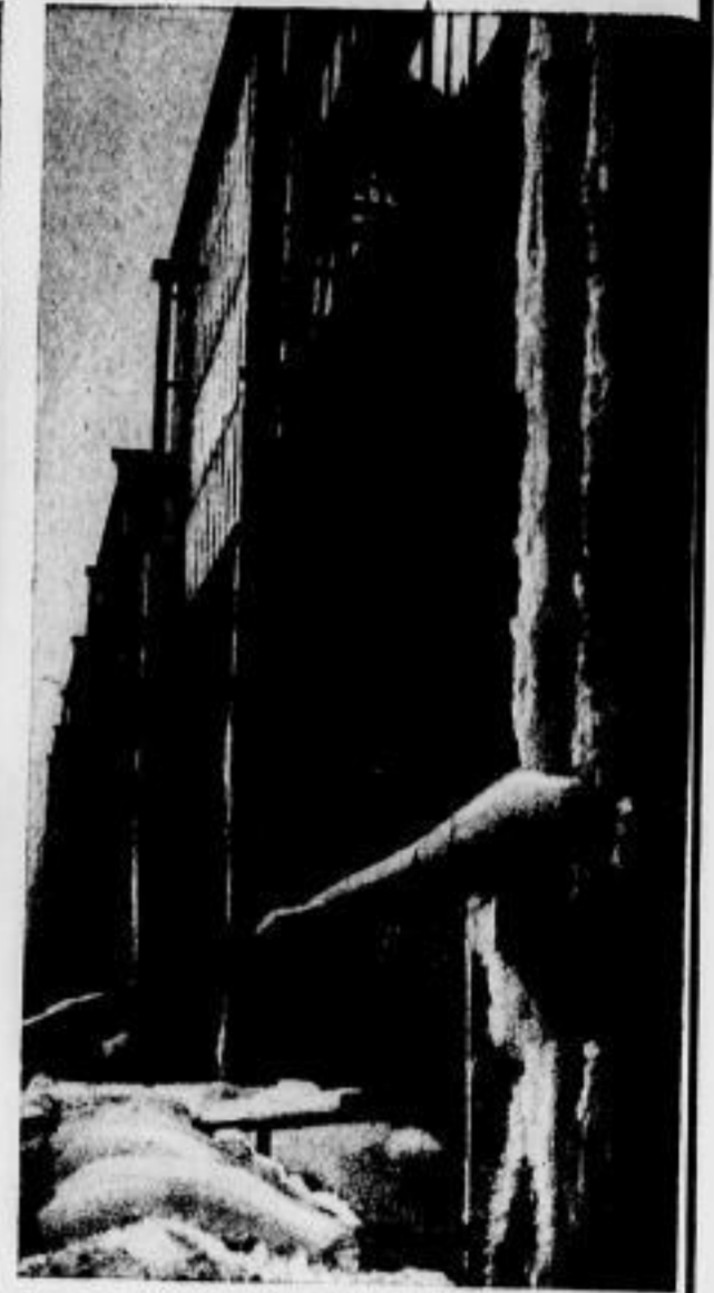
Bild rechts: Besonderes Interesse fand diesmal die Baumesse. Ein Rekordbau war die dafür geschaffene neue Riesenhalle. Der gefrorene Boden mußte erst mit Pflastersteinen aufgeschichtet werden, trotzdem war der Bau in knapp drei Monaten fertig. — Die Seitenfront beim Bau. Das Oberstiel besteht ganz aus Glas
