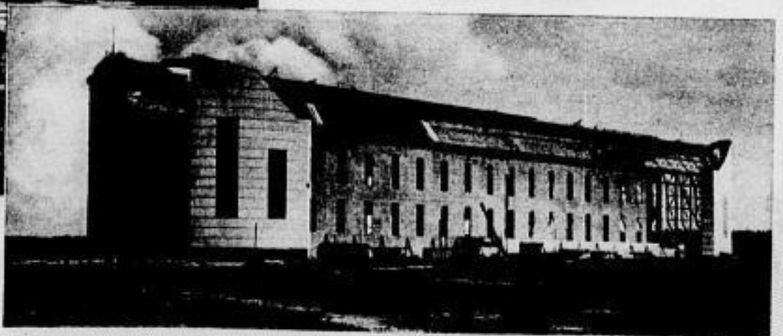
Bild unten: Die neue Riesenhalle für das kommende Luftschiff geht auf dem jetzt hergestellten Fluggelände in Löwental bei Friedrichshafen der Vollendung entgegen. Die Halle, bei deren Bau die neuesten Erfahrungen der Technik verwertet wurden, macht in ihren riesigen Ausmaßen einen gewaltigen Eindruck Weiber, Friedrichshafen
