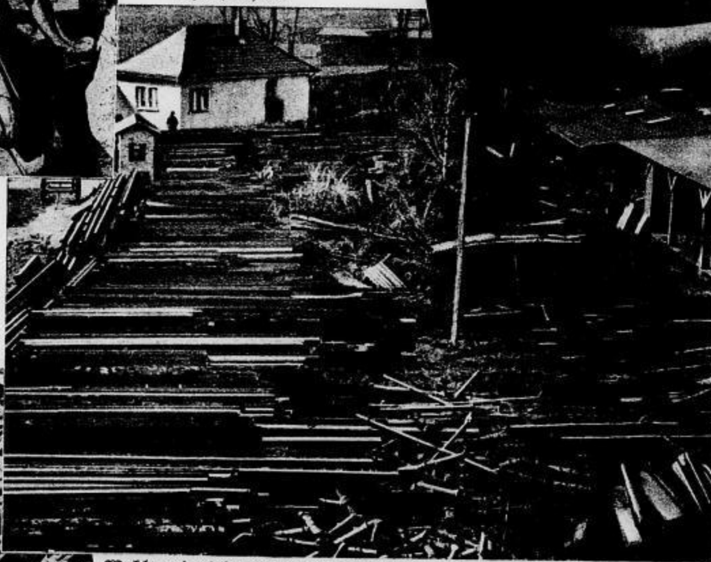
Wohlgeordnet harren die ausgesonderten, noch brauchbaren Teile, hier Eisenschienen und Röhre, neuer Verwendung
