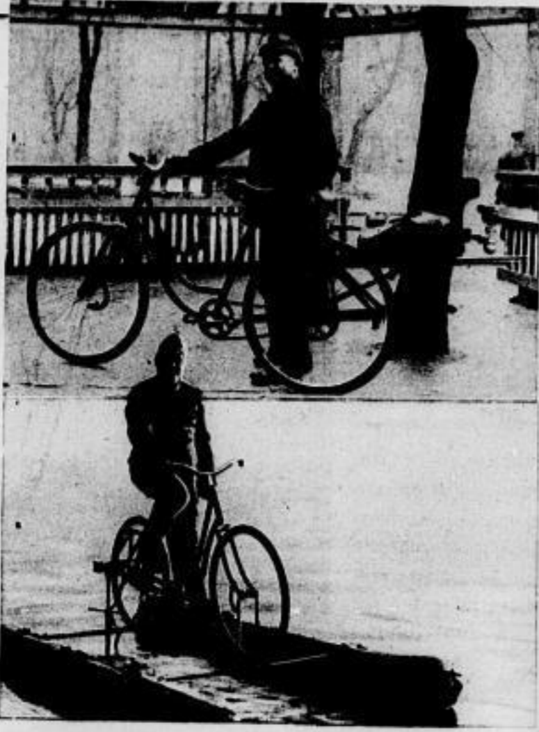
Zu Wasser und zu Land mit dem Fahrrad unterwegs. Ein findiger Führer aus der Gegend von Syd in Schweden baute sich ein Fahrrad, dessen Pedale auch eine niederklappbare Zweiflügel-Schraube antreiben. So kann das Fahrrad auch im Wasser benutzt werden, wo es auf zwei luftgefüllten Gummitüfen ruht. S. B. D.
