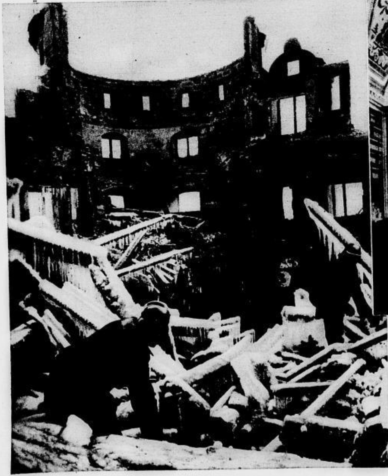
Ein Sturzungsfall im Vatikan. In der Vatikanischen Bibliothek stürzte kürzlich eine große Saaldecke ein. Das Unglück forderte fünf Todesopfer. Etwa 15000 kostbare Bücher sind verschüttet und zum großen Teil völlig vernichtet. S.B.D.
