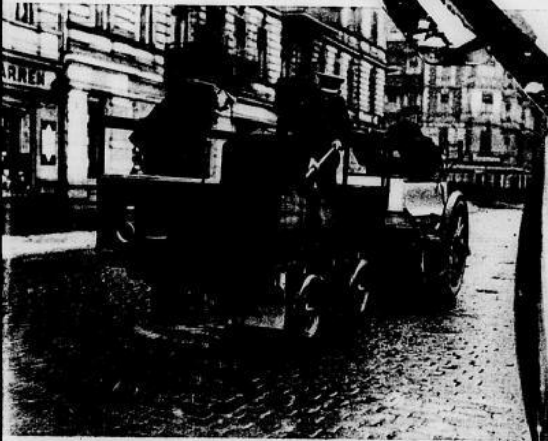
Kampf dem Glatteis. Ein kreisendes Rad streut den im Wagen aufgespeicherten Sand fein verteilt über die halbe Straßenbreite, so daß der großstädtische Damm dem Verkehr wieder gewachsen ist. E.
