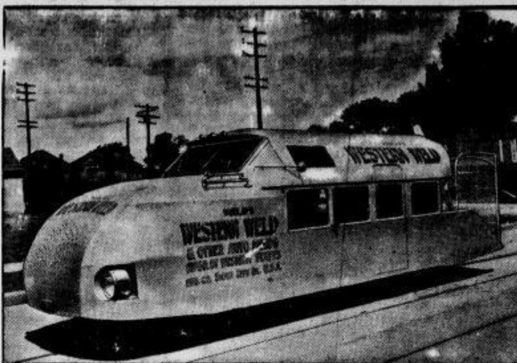
Das seltsame Auto, das der Amerikaner W. Anderson in Form eines Zeppelins baute. Das Gefährt wird von einem Propeller vorwärts getrieben, der wiederum durch einen Flugzeugmotor seinen Antrieb erhält.
