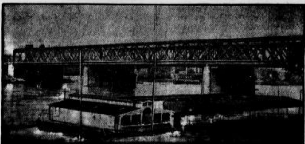
Blick auf die umgebante Brücke, die den gesamten Eisenbahn-, Straßenbahn-, Fußgänger- und Autoverkehr zwischen Mannheim und Ludwigshafen aufnehmen hat. Die Brücke wird in ihrer neuen Gestalt in Anwesenheit von Vertretern des Reiches und der Landesregierungen von Bayern und Baden am Sonntag eingeweiht werden.
