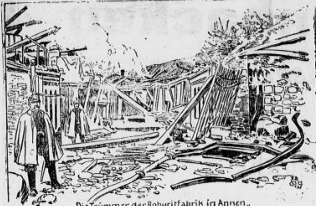
Die Trümmer der Roburitfabrik in Annen.
