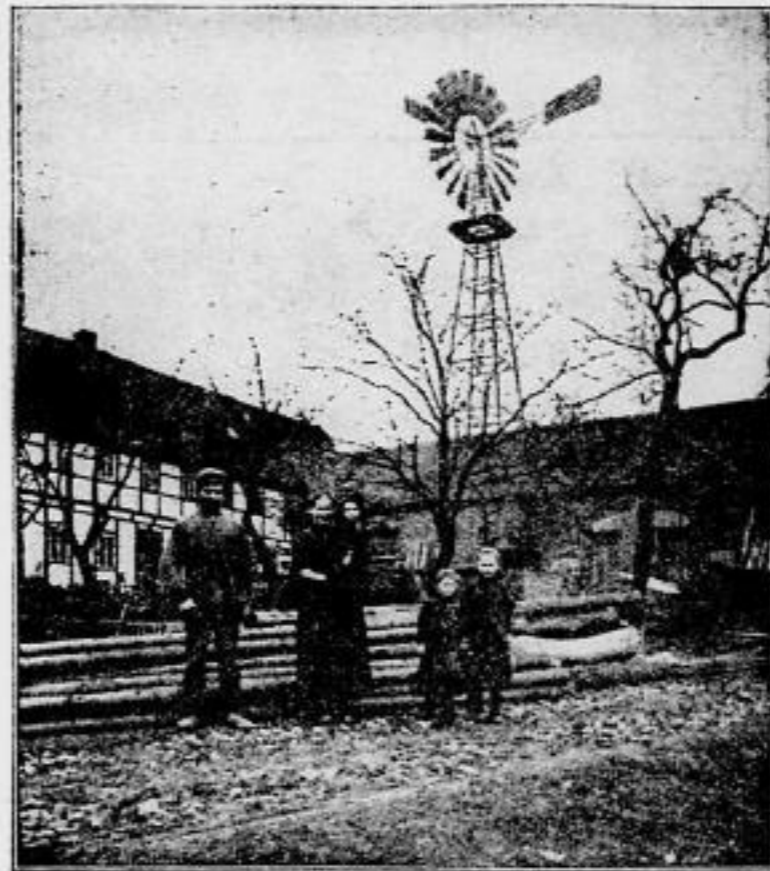
Anlage des Herrn Stellmachermeister Rich. Thimmig in Neukirchen b. Deutschenbora zum Antrieb einer Gattersäge und anderer Holzbearbeitungs- und landwirtschaftl. Maschinen.
