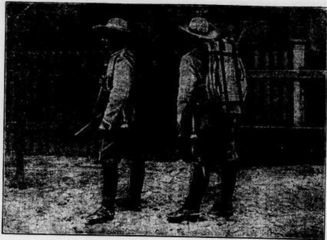
Die Trinkwasserbereitung in Deutsch-Südwestafrika: Apparate zur Trinkwasserbereitung von 2 Mann getragen, pro Mann ca. 23 Kilo.
