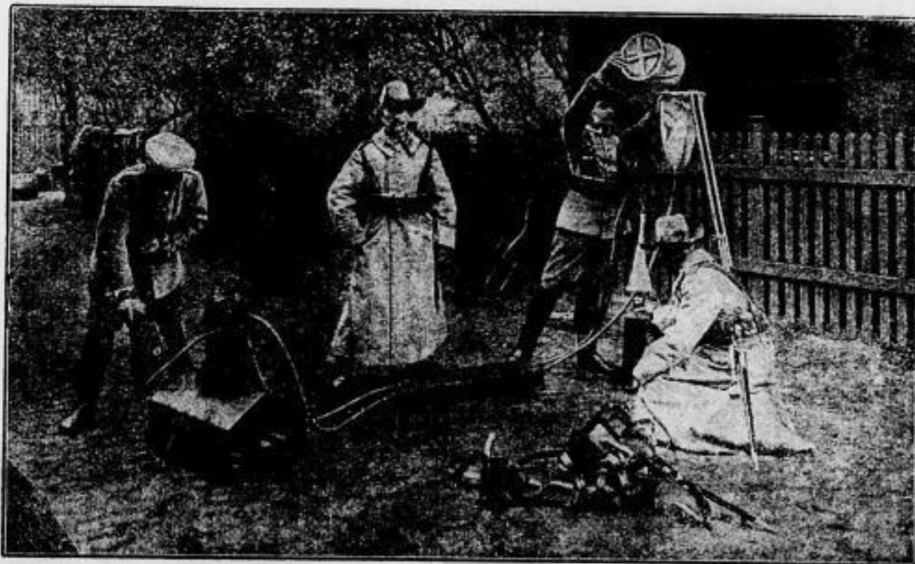
Die Trinkwasserbereitung in Deutsch-Südwestafrika: Die Mannschaft bei der Bereitung von Trinkwasser. (Text nebenstehend.)
