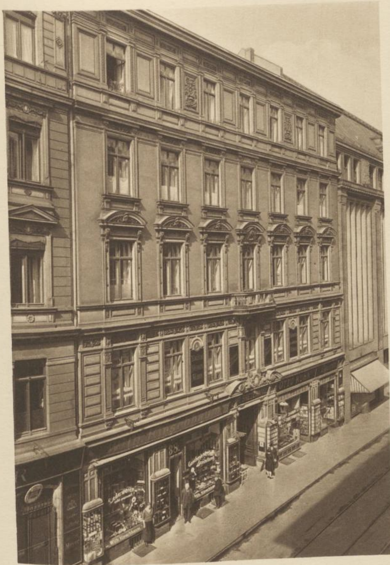
Das Haus am Neumarkt Nr. 38 Heim der Handelskammer von 1868 bis 1886
