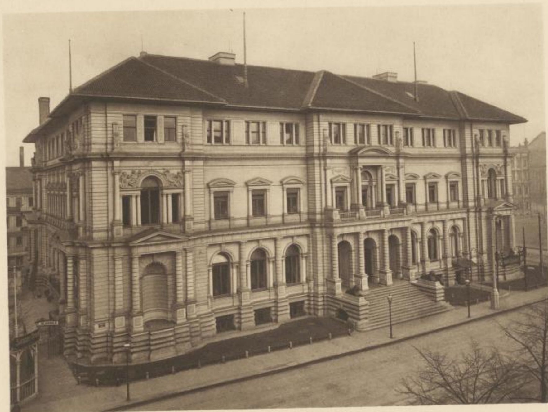
Die Neue Börse Heim der Handelskammer Nach dem Umbau vom Jahre 1910/11
