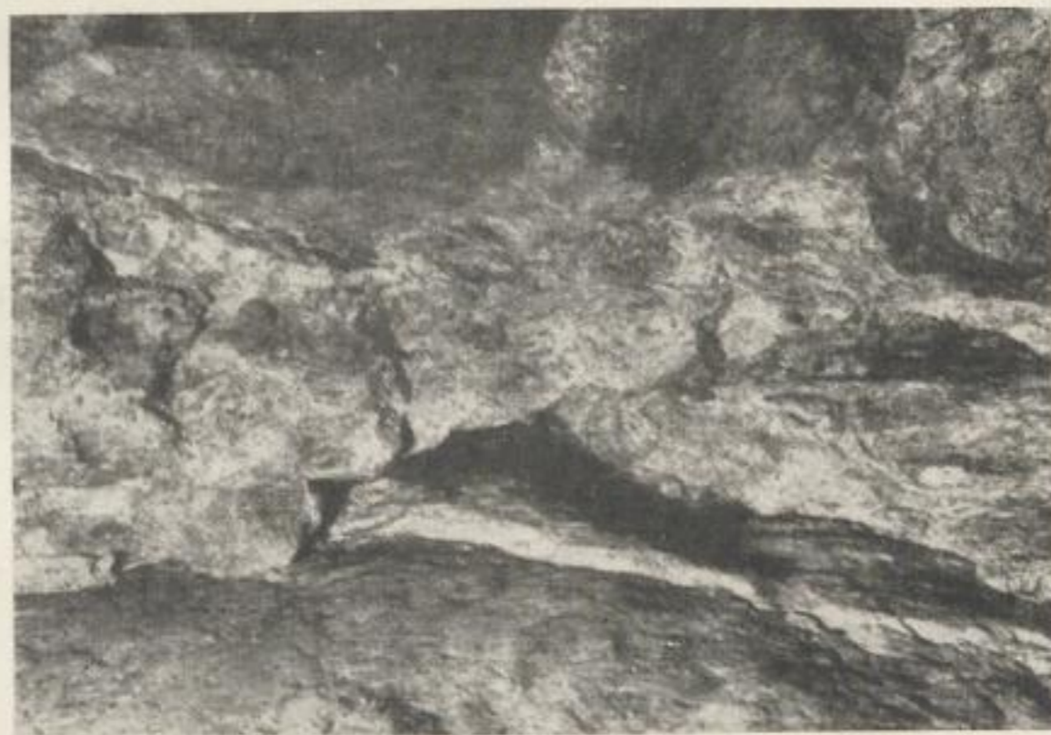
Bild 17 M. 1 : 10 Horizontale Harnischbildung am Hauptstollgang Sth. (Revier Freiberg, 8. Gez.-Str.). Starke Ruschelbildung, geringe Vererzung. Die horizontale Riefung am liegenden Salband zeigt, daß es sich hier um eine Blattverschiebung handelt
