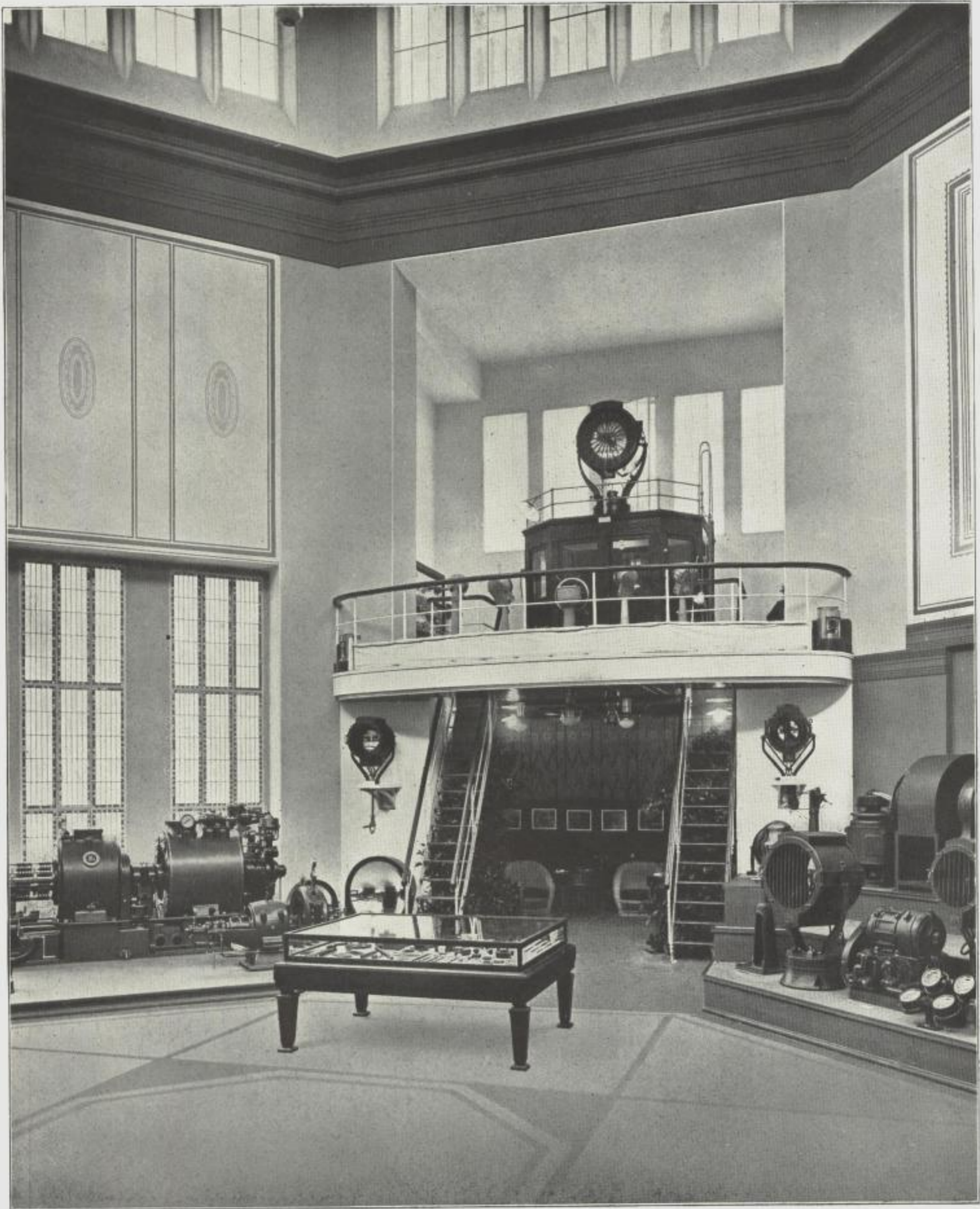
Inneres des Pavillons der A E G auf der Schiffsbauausstellung Berlin 1909.
