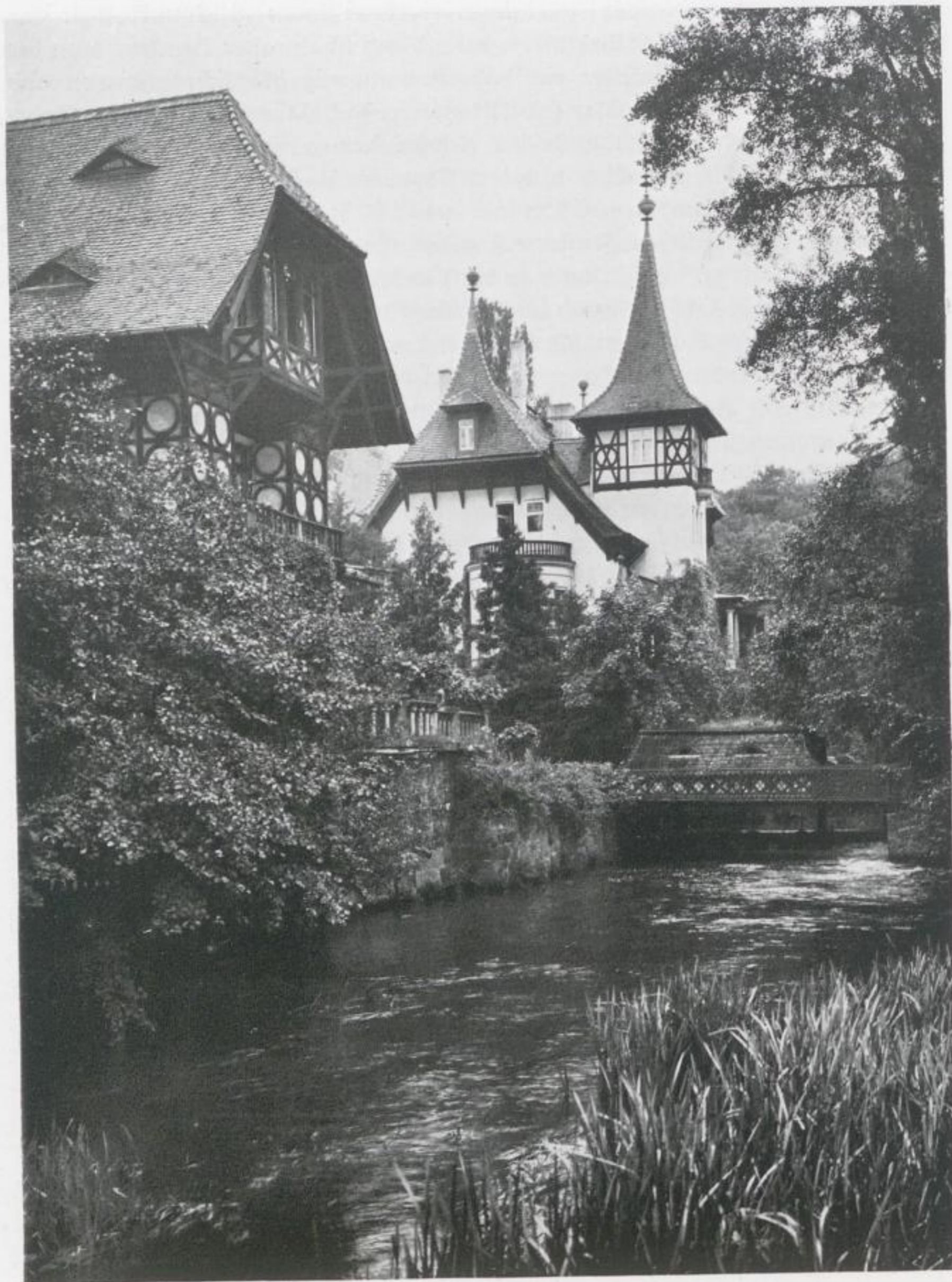
Blick von der Pleißenbrücke bei Leipzig-Lößnig flussaufwärts (Villen um 1890 von den Familien Limburger und Tauchnitz errichtet)
