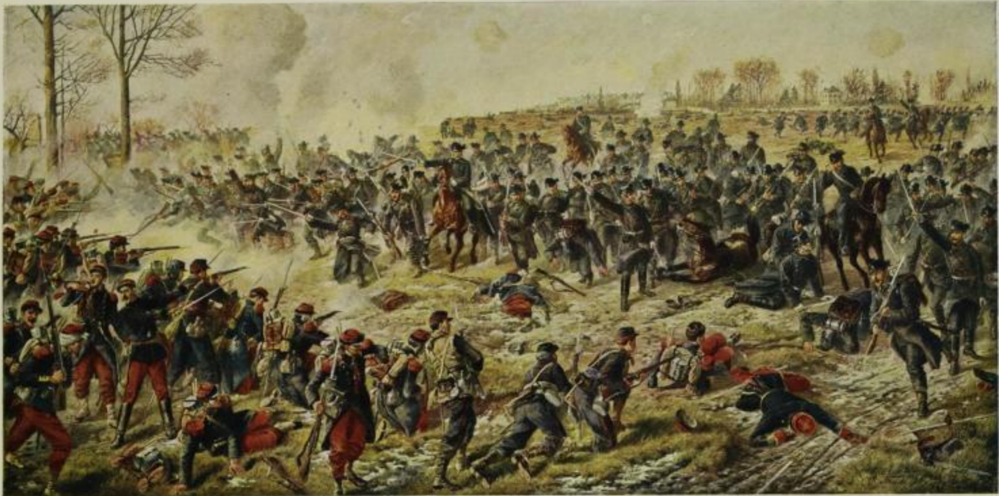
Das Schützen-Regt. auf der Hochfläche von Villiers s/Marne am 2.12.1870.
