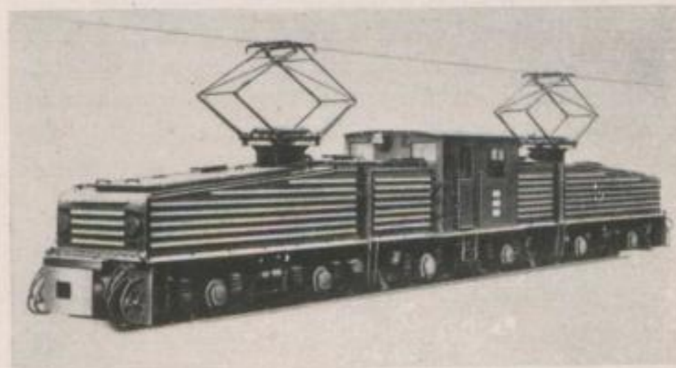
Bild 2. Elektrische Tagebaulokomotive EL 10 (SSW) Spurweite 900 mm; Dienstgewicht 120 t; Stundenzugkraft 18,2 t; Baujahr 1952
