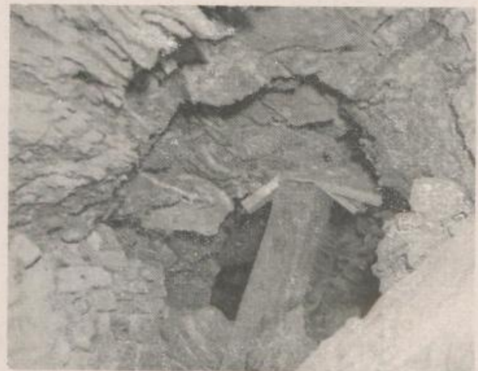
Bild 4. Nahezu bruchlose Verformung des Carnallits (Grube Großschießstedt, Abbau südlich der Strecke 58)
