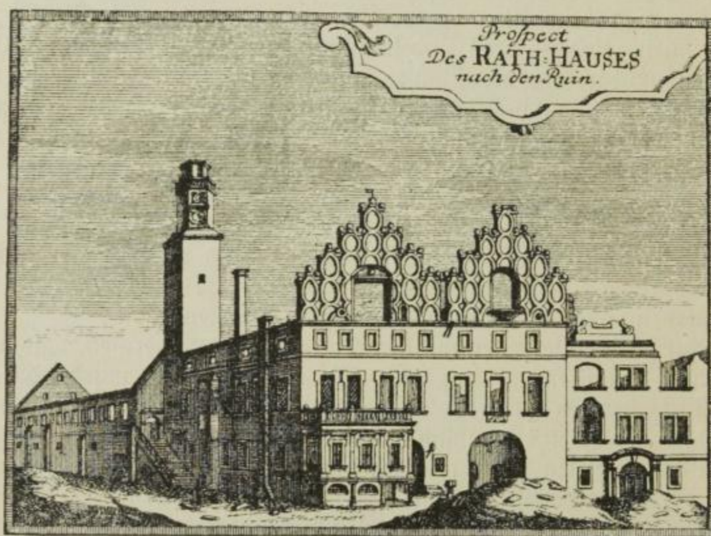
135. Das Zittauer Rathaus nach der Beschädigung (s. Bild 108).
