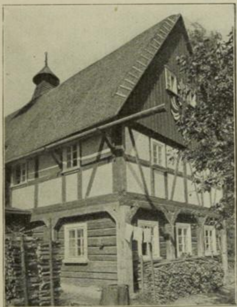
24. Haus in Dobin (Nr. 132) Schornstein mit Dach.
