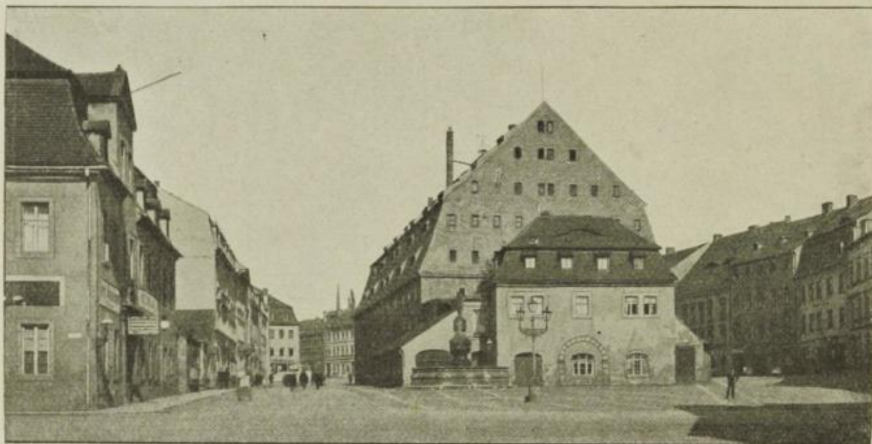
10. Marstall und ehemalige Stadtschmiede.
