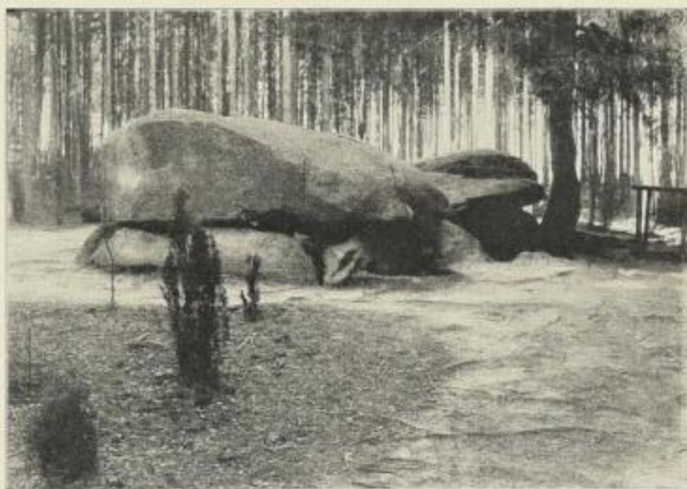
Eins der Sieben Steinhäuser.
