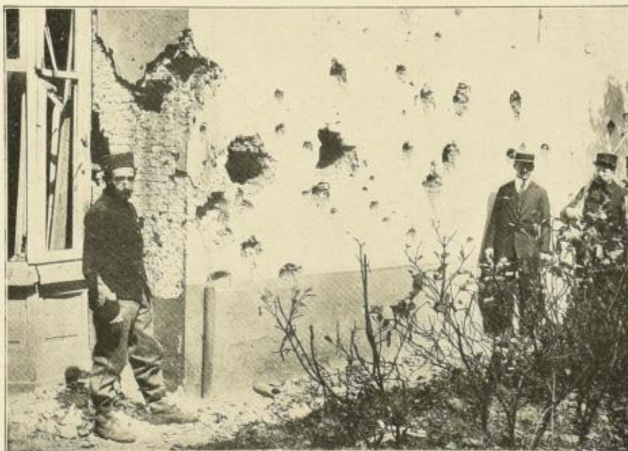
Beschädigung eines Hauses in Antwerpen durch eine Bombe. Nach einer Photographie.
