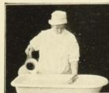
Bad, Prüfen der Wärme des Wassers
