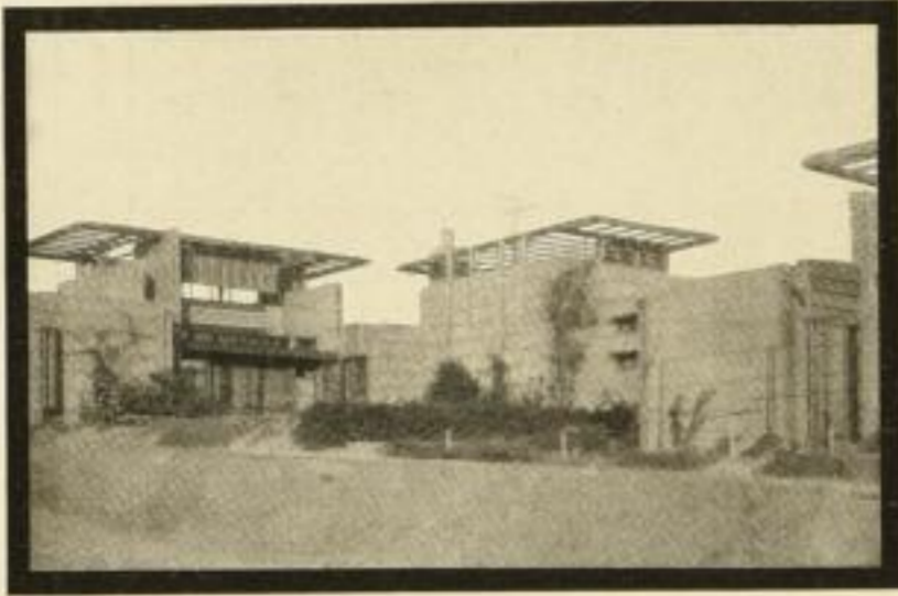
Einheitliche Hausgruppe, in Beton mit Gleitverschalung erbaut
