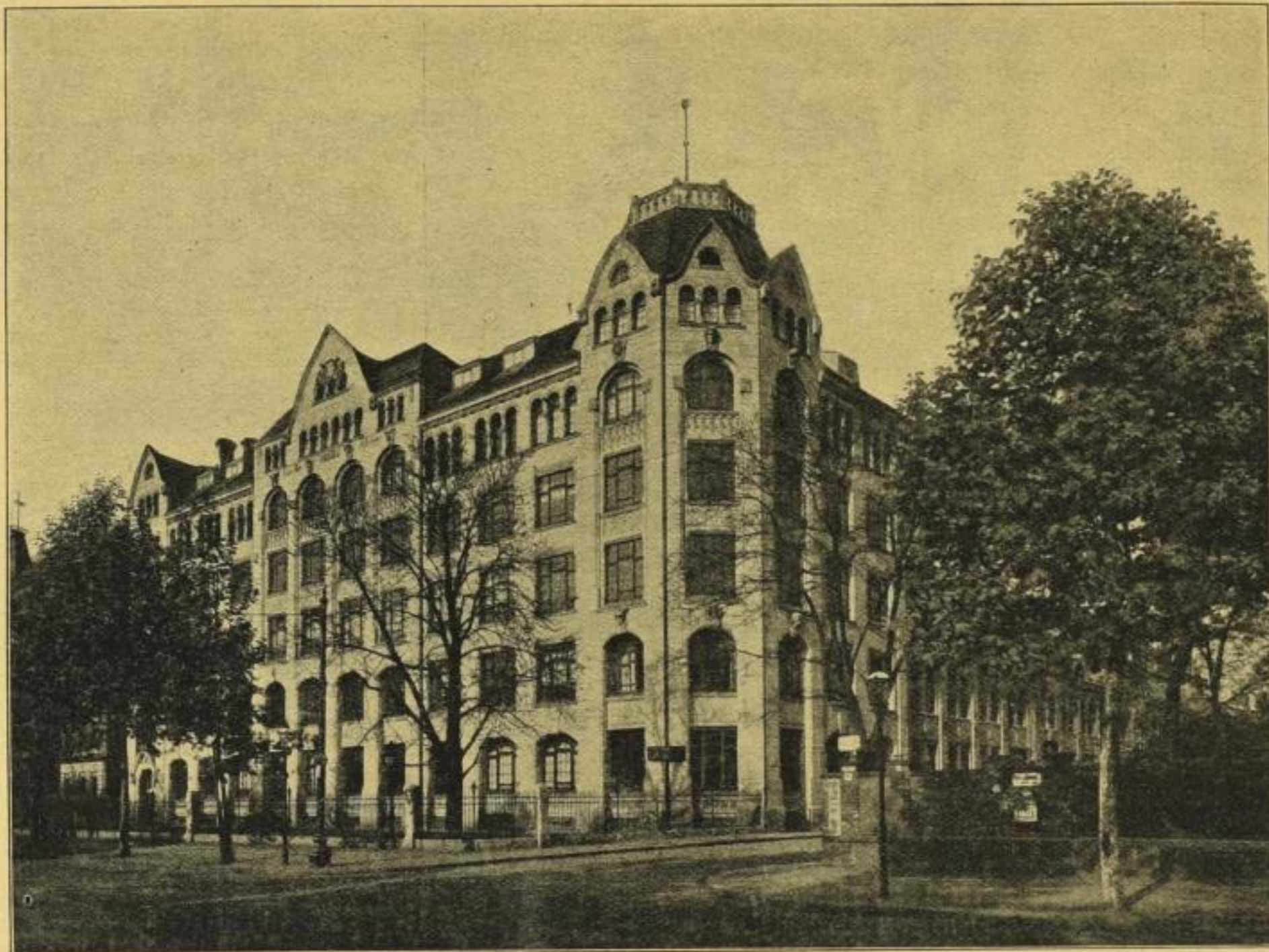
Dresdner Straßen-Flügel des Druckereigebäudes.
