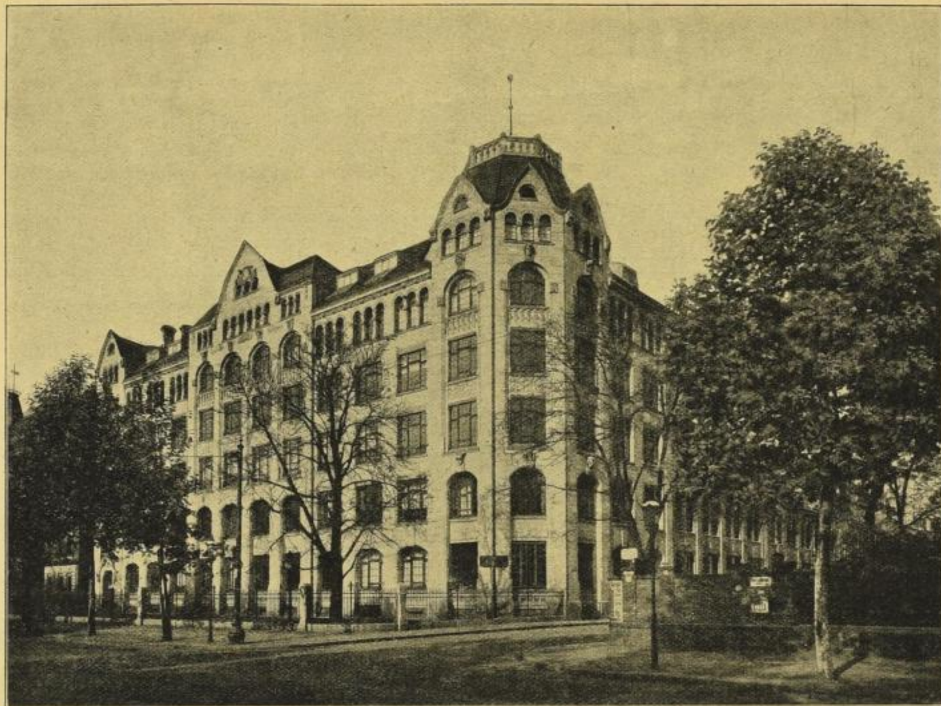
Dresdner Straßen-Flügel des Druckereigebäudes.
