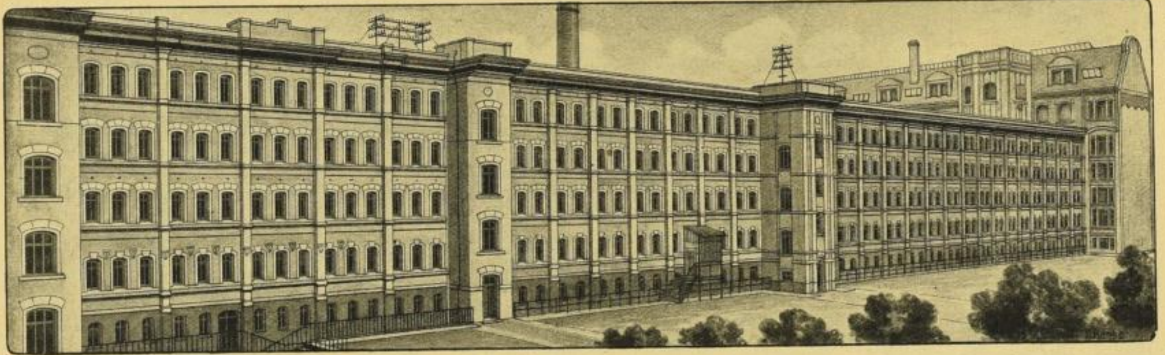
Inselstrasse — Hofflügel des Druckerei-Gebäudes (108 m Länge)
