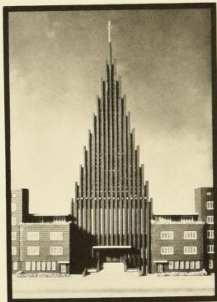
FRANKFURT (MAIN) - BORNHEIM, HEILIGKREUZKIRCHE ARCHITEKT MARTIN WEBER
