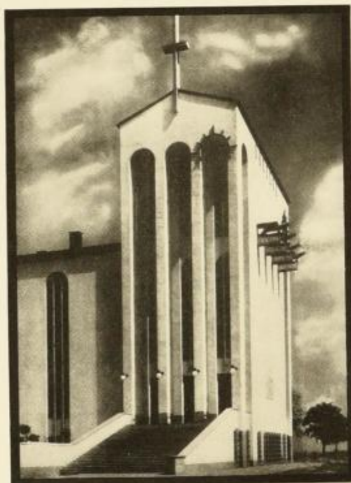
KIRCHE HAMBURG - HAMM ARCHITEKT FRITZ HÖGER
